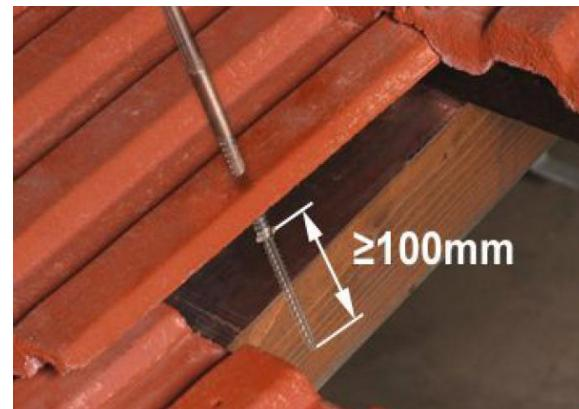
**5 – Otvor ve střešní tašce se utěsní pomocí těsnící gumy, která se přitlačí maticí a podložkou.**
